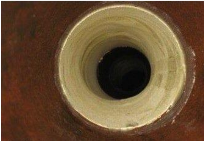
Nach Wurzelbeseitigung/Sanierung
