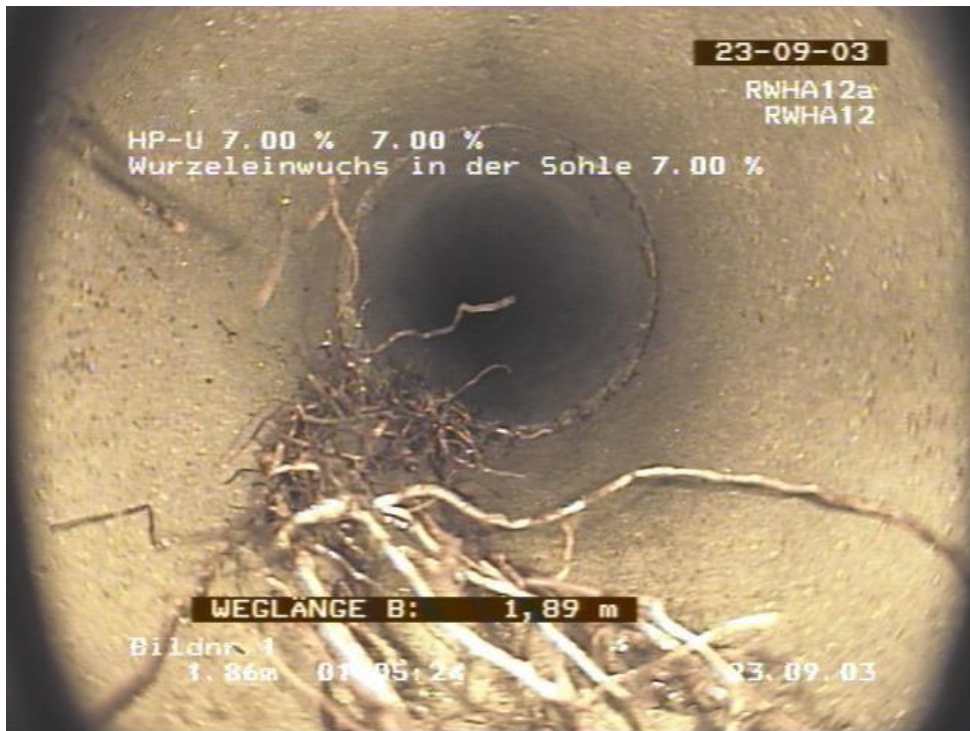
„TV-Kanalinspektion“ ( www.reichel-abwassertechnik.de )
