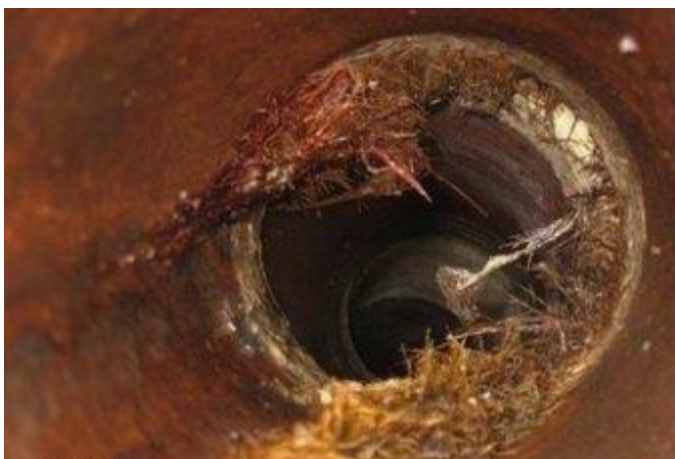
Vor Wurzelbeseitigung / Sanierungsmaßnahme
